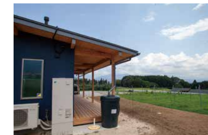
雨樋からの雨水を集めて利用できるように雨水タンクを設置
