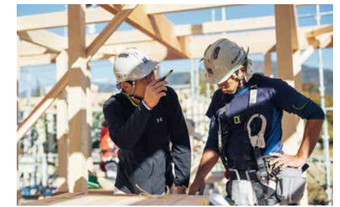
工事の進捗納まりを現場で職人と話し合います。
