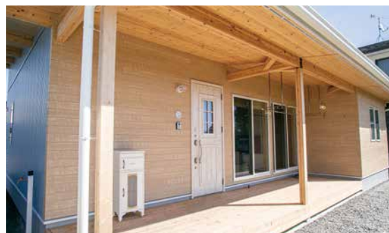
リビング前に大きく出た屋根。室内を快適にしてくれます
