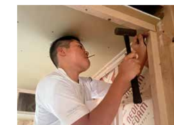
釘1本1本心を込めて施工します。
