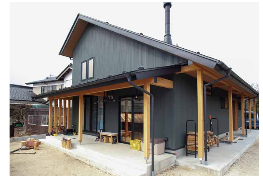
広い土間と下屋。薪置き場としても使いやすいです
