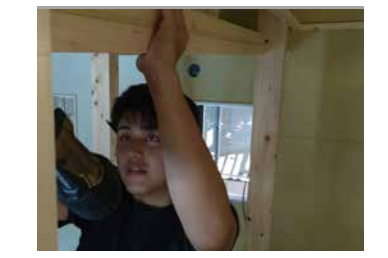
丁寧に、慎重に、施工方法を確認し作業を進めています
