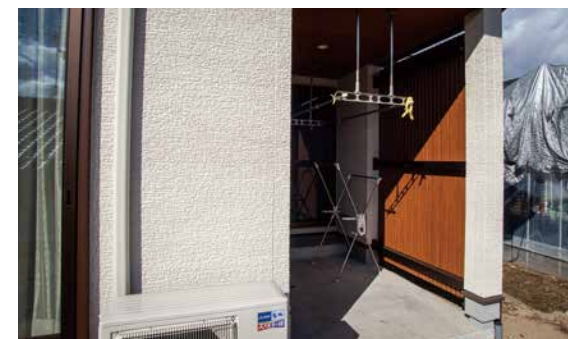
周りからは見えにくい物干し場。 木ルーバーなので風が通り抜けます
