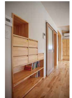
階段下を有効活用し 収納スペースに
