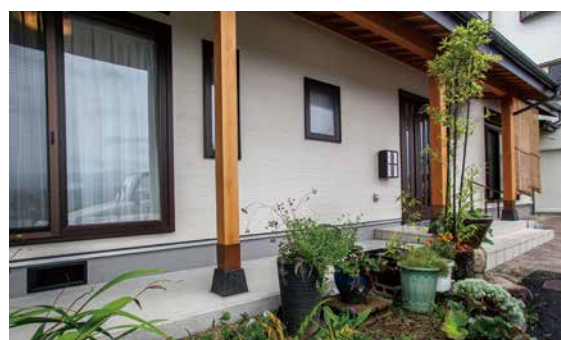
日のよく当たる南側には差掛け屋根を設置。季節に対応して快適です
