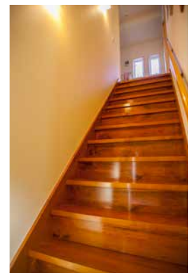
階段は既存のものをそのまま使用、巾も広くとても使いやすい。
