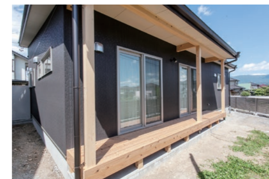
家の裏側にはウッドデッキスタイルの縁側を設置。陽当たりの良い日は気持ちがいい。
