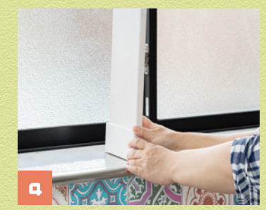
4 上側に押し付けるようにして下側をスライドさせます。もし緩い場合は付属のスペーサーを使って調整します。
