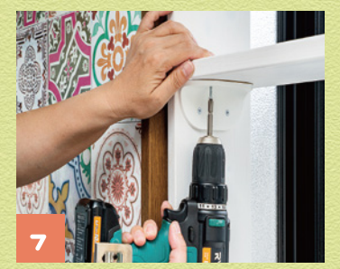
7 棚板をのせて、下からネジをとめて固定します。使い勝手に合わせて、後からでも棚を増やすことができます。
