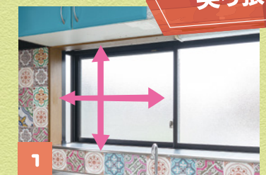
1 設置したい場所の寸法を測ります。高さは出来るだけ正確に測りましょう。柱になる材料は測った実寸よりも短くカットします。カットする寸法は説明書を参照してください。ホームセンターでカットをお願いすると時短になります。
