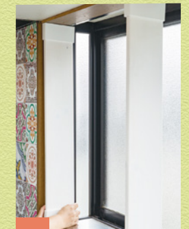
5 もう一方の柱は棚の長さ位置に合わせて設置します。
