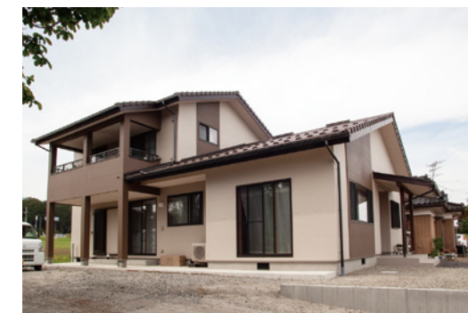
切妻屋根がキリッとした印象の外観。 大きなバルコニーが魅力的。
